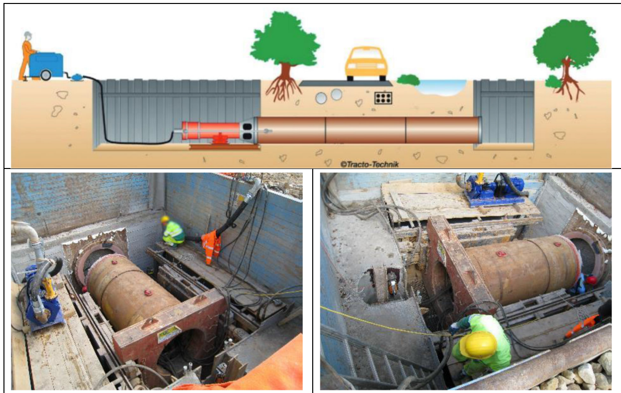
Abbildung 1: Schema grabenloses Bauverfahren (Rammvortrieb) [6] sowie Beispielfotos einer Straßenunterpressung (Leitungsdurchmesser DN1000)
